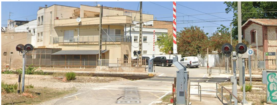
Pas a nivell de l'estació de Camp-redó
