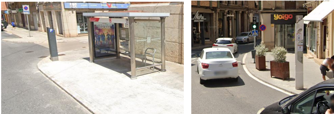
Figura 104. Parada C. Tarragona 8 amb marquesina (esquerra) i Pl. Constitució amb pal de parada (dreta). Font: Elaboració pròpia
