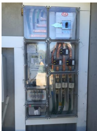
Figura 7. Comptador elèctric
