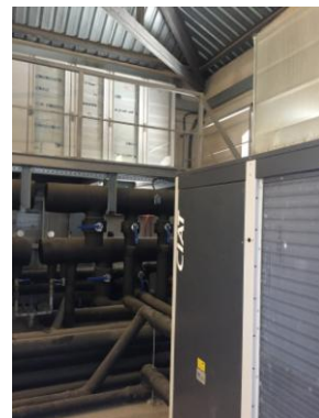
Figura 6. Bomba de calor aire- aigua
