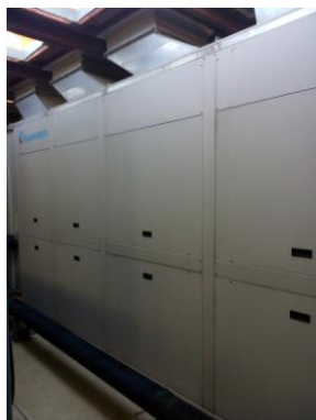
Figura 5. Bomba de calor aire- aigua
