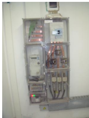
Figura 9. Comptador elèctric
