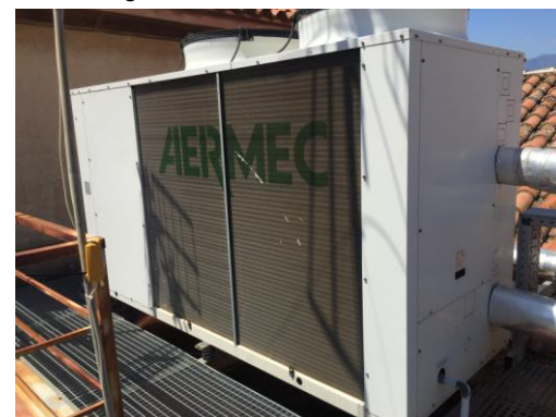
Figura 6. Bomba de calor aire- aigua
