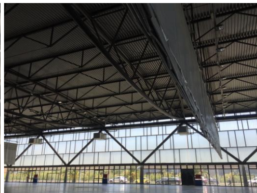
Figura 4. Unitats terminals aerotermos
