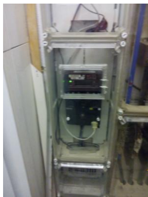
Figura 6. Comptador elèctric
